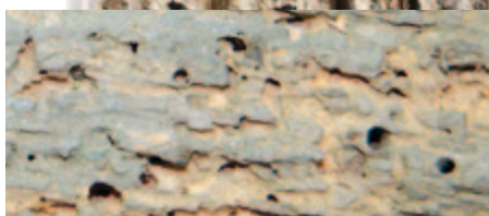
Fori di sfarfallamento
