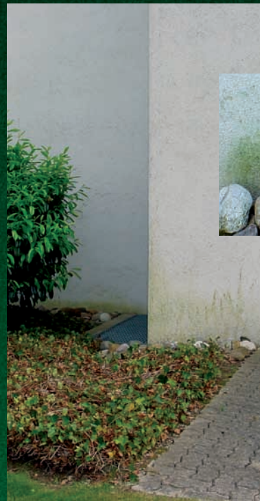
Sockelbereich vor Spritzwasser schützen
