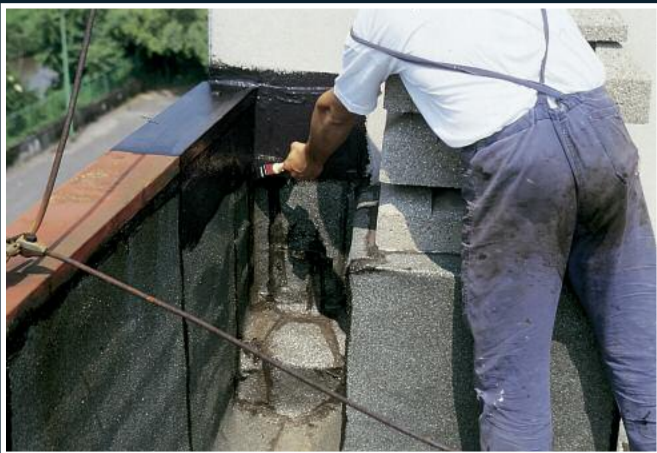
L'impermeabilizzazione di superfici irregolari
