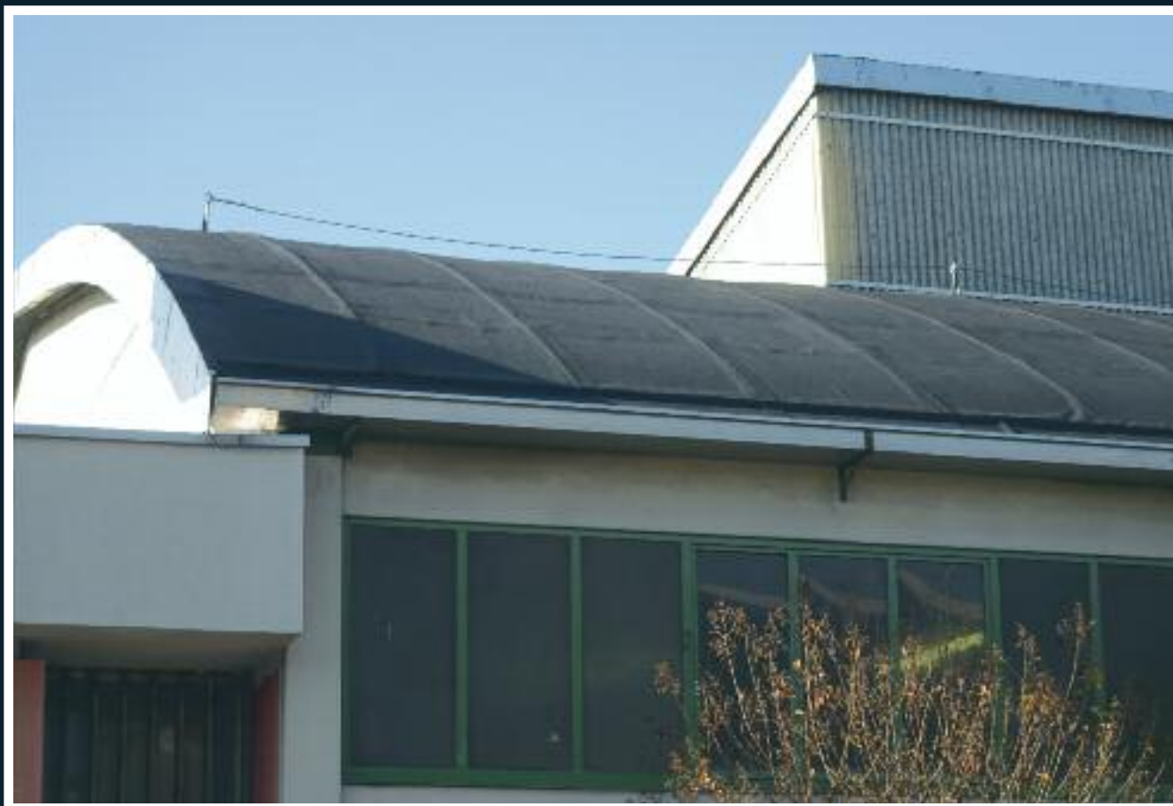
Nelle manutenzioni per il rinnovamento delle guaine bituminose invecchiate
