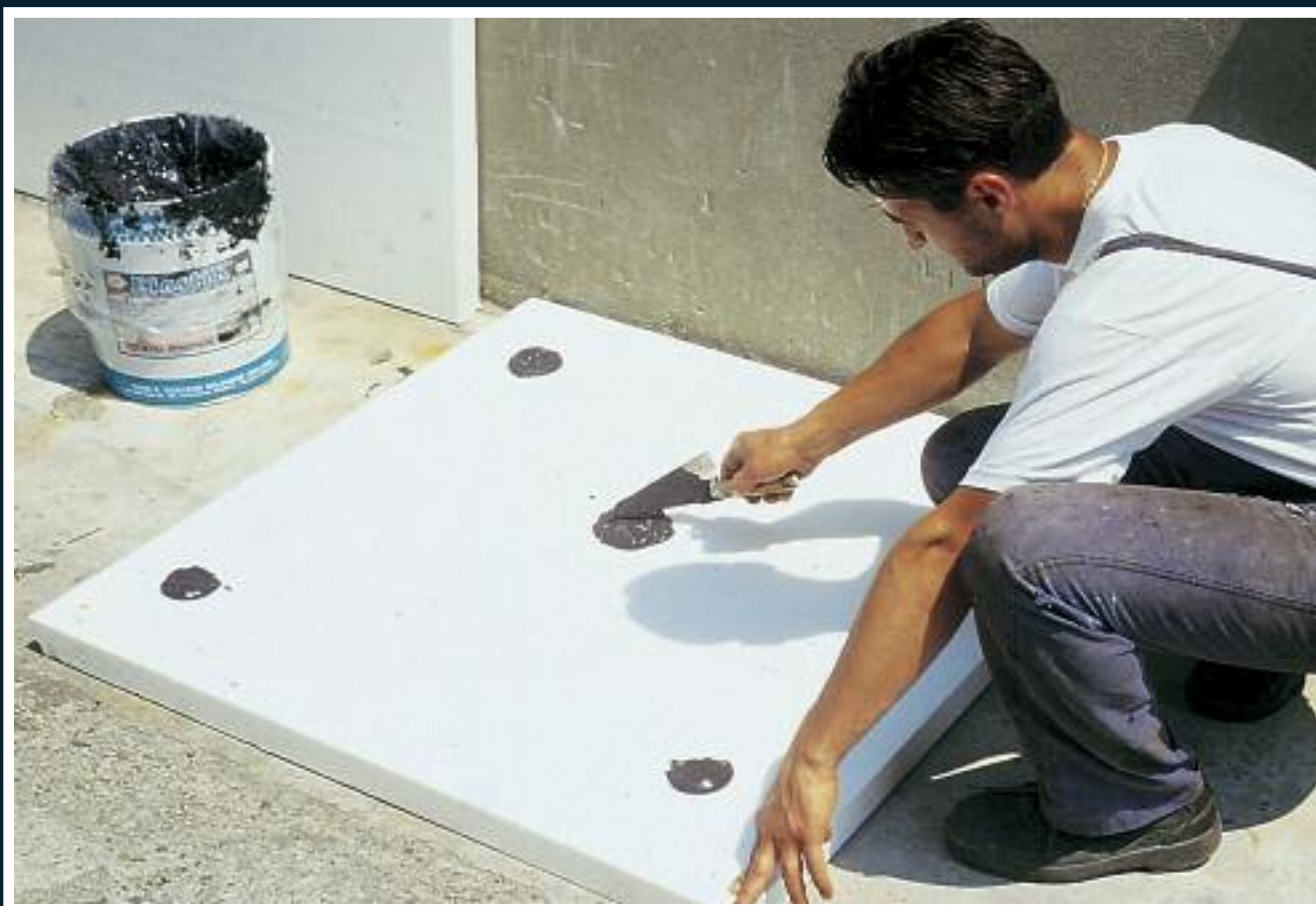
L'incollaggio di pannelli isolanti su superfici traspiranti (cemento, legno)
