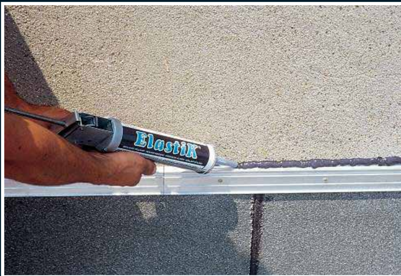
La sigillatura impermeabile dei particolari anche umidi
