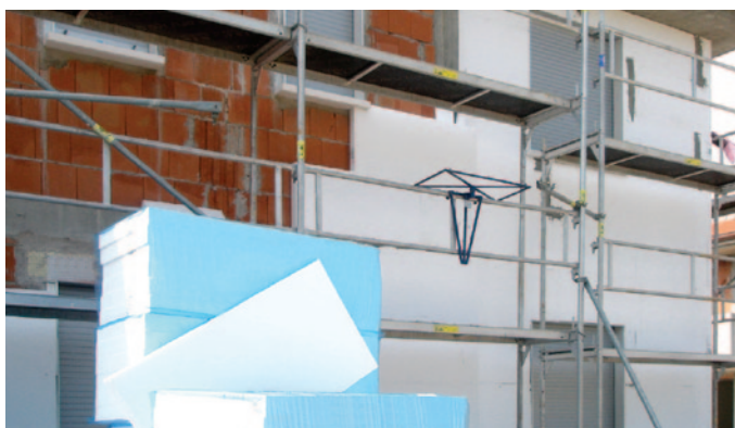
Posa sfalsata dei pannelli.
