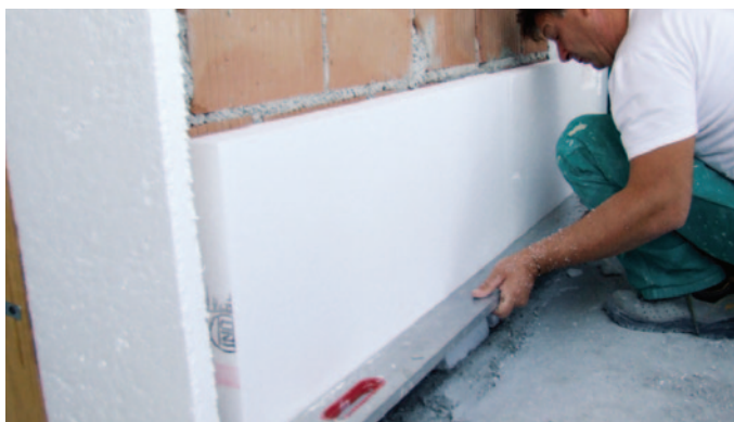
Incollaggio e posa dei pannelli.
